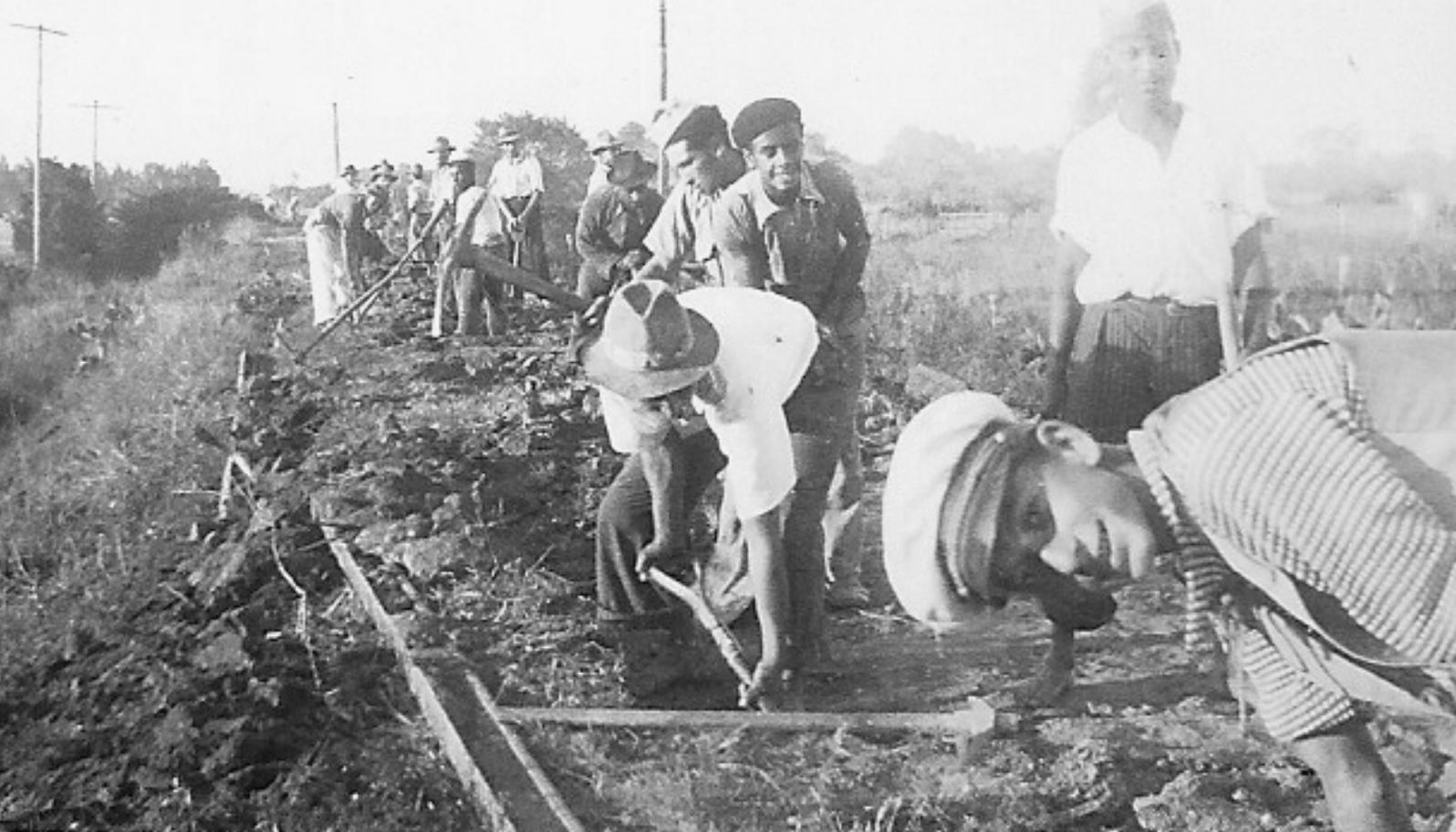
FIGURA 140. Trabalhadores no processo de construção da ferrovia Pelotas-Canguçu.
