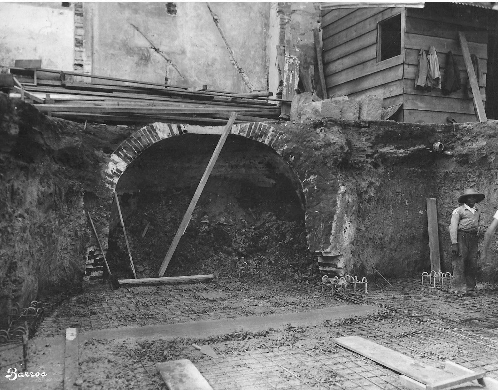
**FIGURA 53.** Andamento das obras de construção do Palácio do Comércio. Autoria da foto: Barros (assinada). Vemos, à direita, acima, no nível do solo, uma casinha de madeira construída para apoio às obras, com os casacos dos trabalhadores pendurados.
