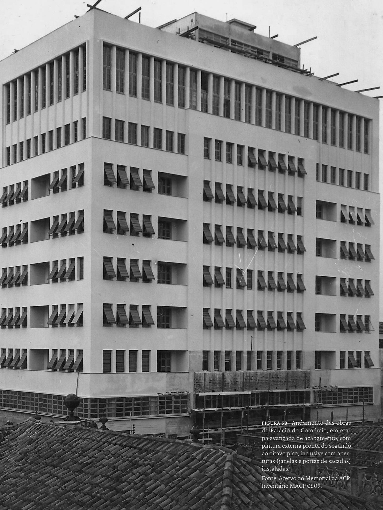
FIGURA 58. Andamento das obras do Palácio do Comércio, em etapa avançada de acabamento, com pintura externa pronta do segundo ao oitavo piso, inclusive com aberturas (janelas e portas de sacadas) instaladas.
