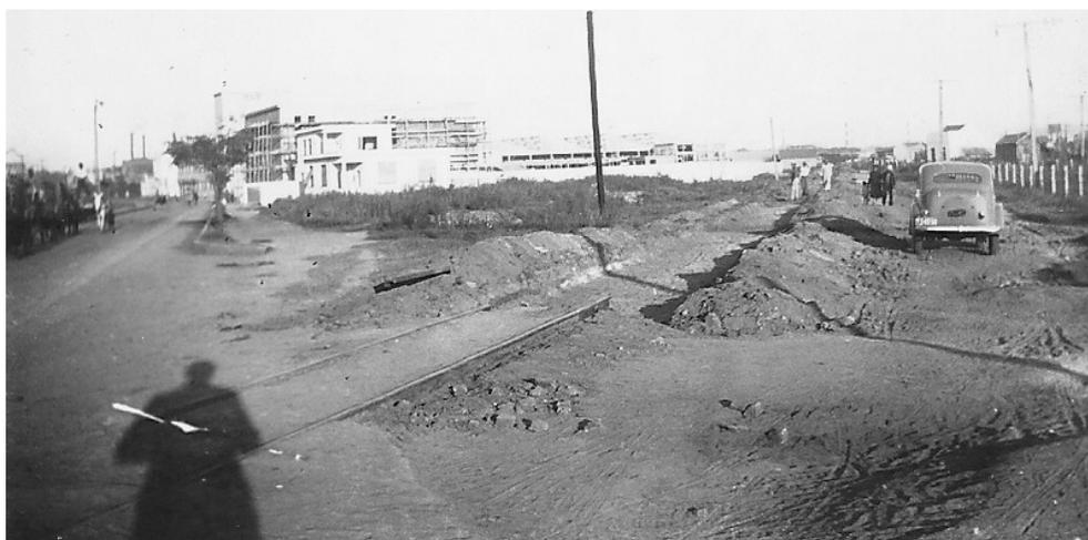
FIGURA 137. Estabelecimento do leito da ferrovia Pelotas-Canguçu (década de 1940).
