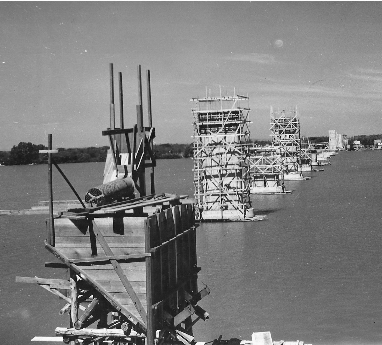
FIGURA 173. Construção das vigas de sustentação da ponte sobre o Canal São Gonçalo, em 1958.
