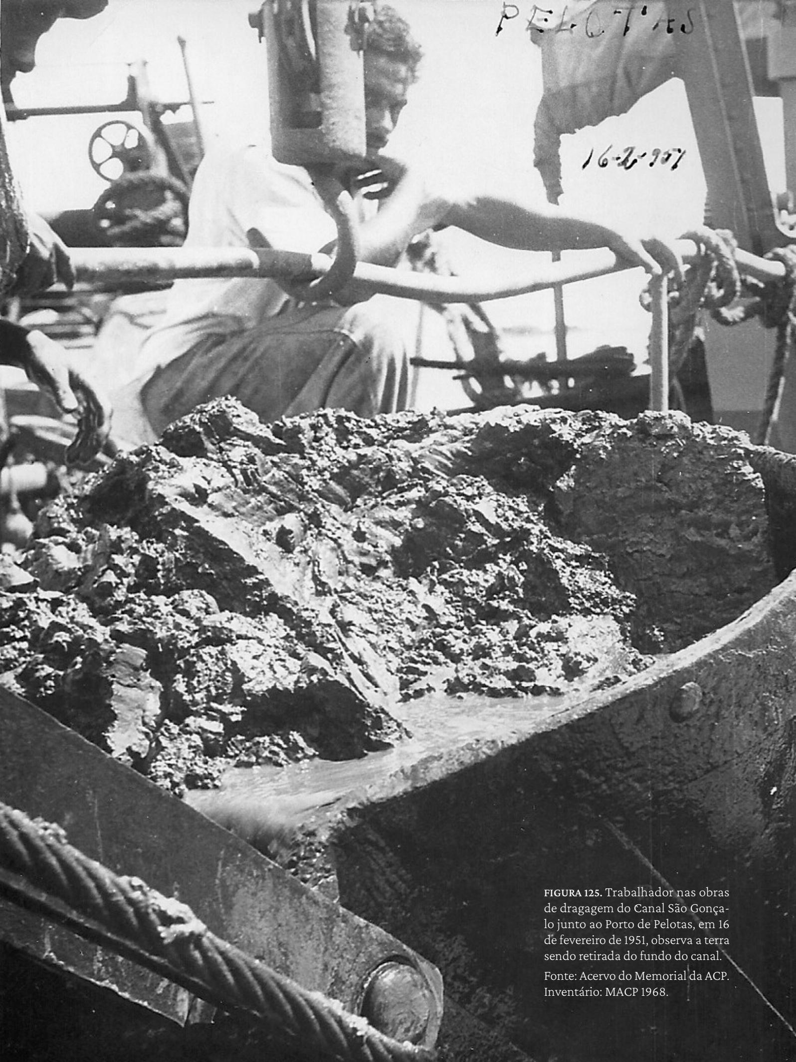
FIGURA 125. Trabalhador nas obras de dragagem do Canal São Gonçalo junto ao Porto de Pelotas, em 16 de fevereiro de 1951, observa a terra sendo retirada do fundo do canal.
