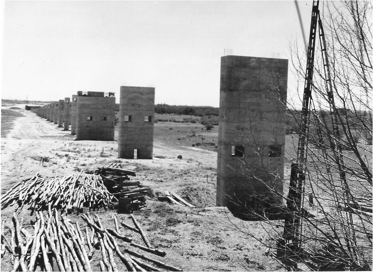
**FIGURA 174.** Construção das vigas de sustentação da ponte sobre o Canal São Gonçalo unindo Pelotas a Rio Grande, iniciada em 1958.
