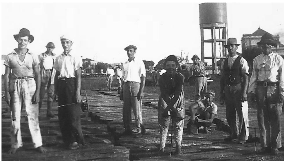
FIGURA 141. Trabalhadores do Batalhão Ferroviário no preparo dos dormentes para os trilhos da ferrovia Pelotas-Canguçu (década de 1940).
